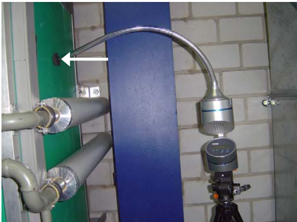
Abb. 13: Luftkeimmessung nach der WRG (vor dem Wärmetauscher)
