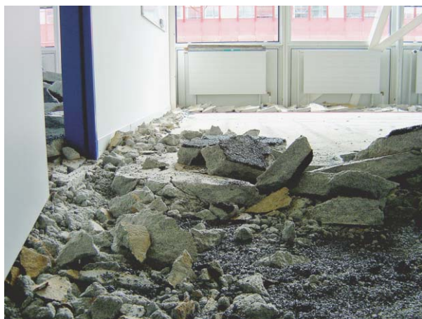
Ausbau der teerhaltigen Dämmung im Unterlagsboden.
