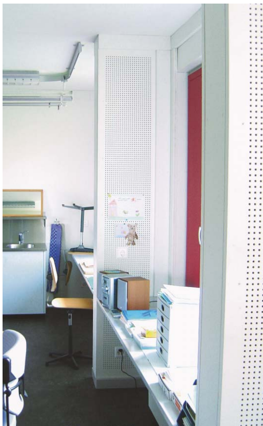
Gelochte Holzwerkstoffplatten können als starke Formaldehydquelle wirken.
